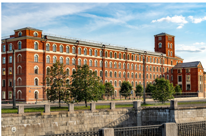
Наб. Обводного канала, д. 60
